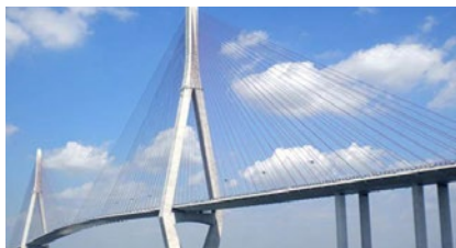
Can Tho Köprüsü, Vietnam ORGA
