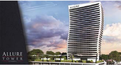
Allure Tower, Orta Yoğunluklu Uçak İkaz Lambası, ORGA
