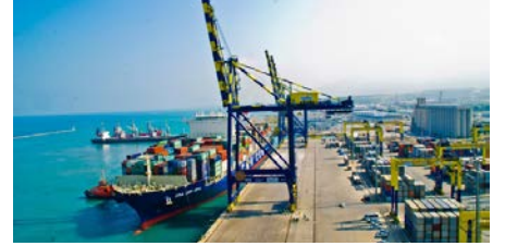
Limak Port, Düşük Yoğunluklu Uçak İkaz Lambası, OBSTA
