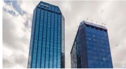
Maya Akar Center, Dual Orta ve Düşük Yoğunluklu Uçak İkaz Lambası ANHANG, BAGLEM
