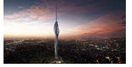
Küçük Çamlıca TV Kulesi, Yüksek Yoğunluklu Uçak İkaz Lambaları, DELTA BOX
